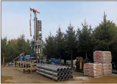
Konec oktobra so gradbeniki izvedli prvo vrtino globine 150 m. Foto: Črtomir Goznik
